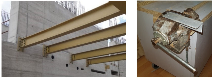
1.61. ábra. Példák befogással modellezhető kapcsolatokra [A48, A49]
